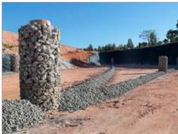
Figura 28 – Dreno de chorume finalizado, com sobressalência de pedra de mão acima do nível do material de cobertura da manta (solo argiloso).
