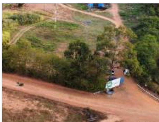
Figura 36 - Entrada do Aterro.
