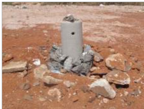
Figura 31 - Manilha de concreto perfurada, envolta na armadura metálica preenchidos com pedra ranchão.
