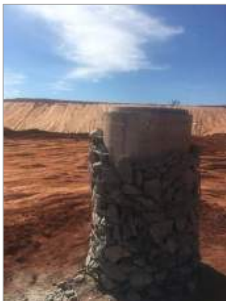
Figura 30 – Manilha de concreto perfurada, envolta na armadura metálica preenchidos com pedra ranchão.
