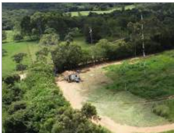
Figura 37 – Portaria existente na área.
