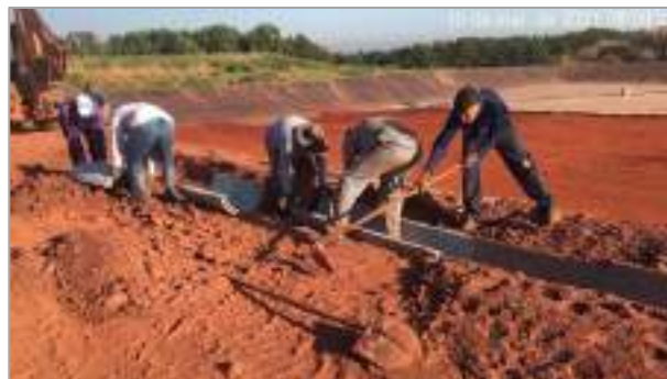
Figura 21 – obras de instalação da manilha meia cana no perímetro da trincheira.
