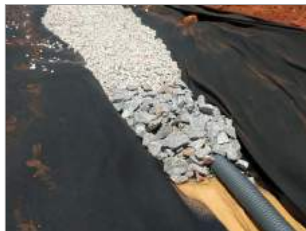
Figura 27 – Preenchimento com brita 4 do dreno de chorume na trincheira.
