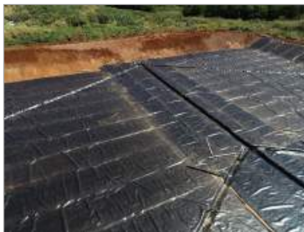
Figura 33 – Exemplo de manta PEAD 2 mm instalada no fundo da trincheira com contornos dos drenos de chorume.
