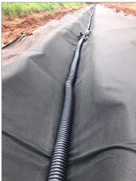
Figura 26 – Tubo PEAD corrugado sob manta de geotêxtil não tecido, durante a montagem do dreno de chorume.
