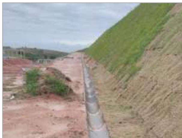
Figura 23 – Modelo de manilha de concreto tipo meia cana instalada em trincheira alteada.
