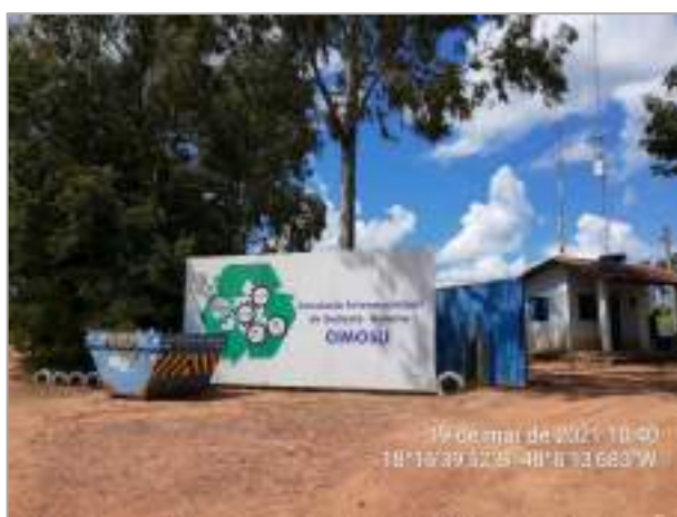
Figura 35 – Entrada do Aterro, portão, guarita.
